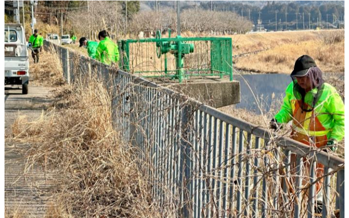
野間川側の柵の下の草刈り、絡みついたマメフジ取り
